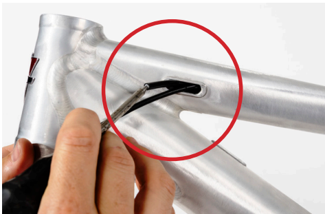
Abb.: Ausgang Bremsleitung Oberrohr.
